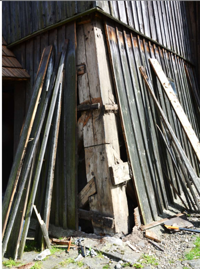
Fot. 10 Słup południowy - - odkrywka 2
