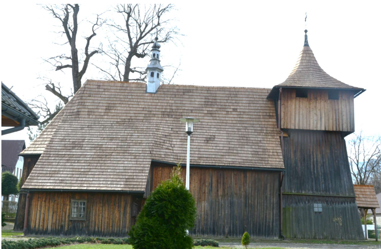
Zdjęcie 1 Kościół, widok od boku obiektu
