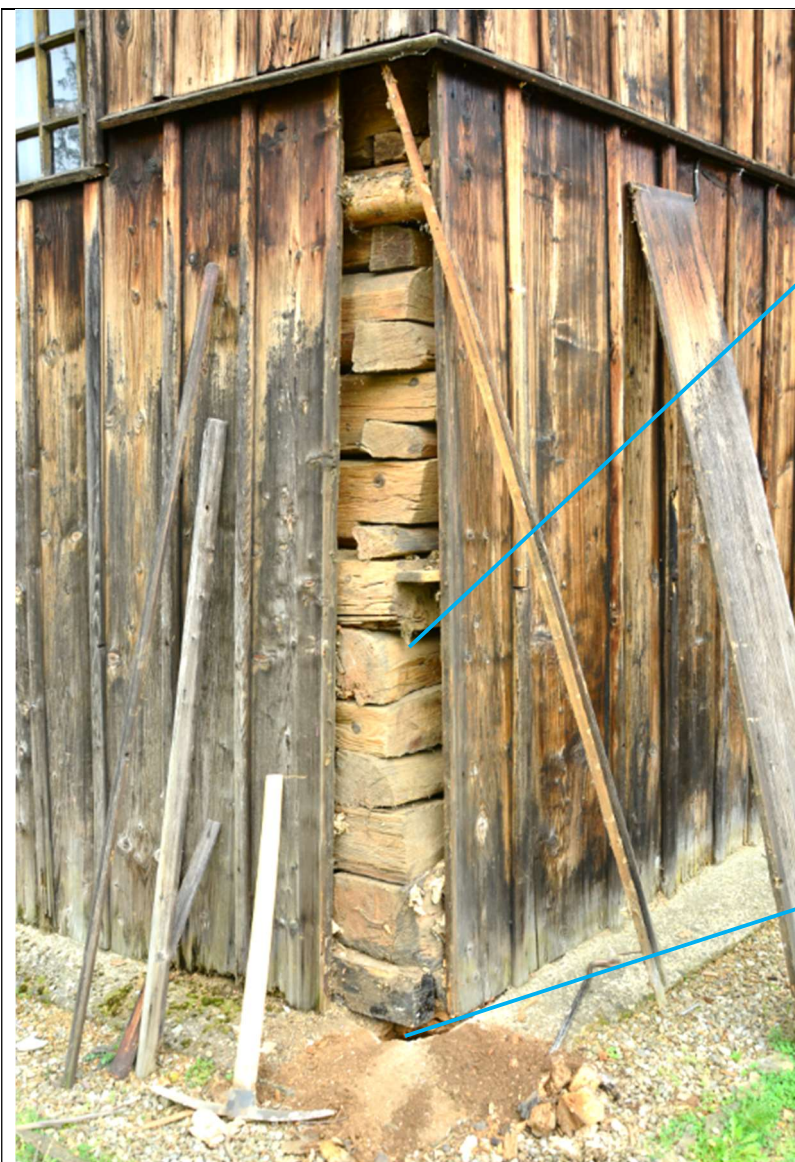
Fot. 20 Odkrywka zrębu, prezbiterium strona wschodnia - odkrywka 7
