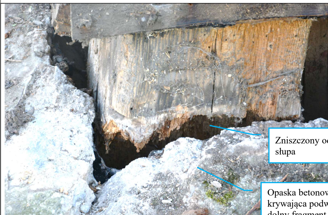
Fot. 7 Zniszczenie dolnego fragmentu słupa pIn zakrytego opaską - odkrywka 1
