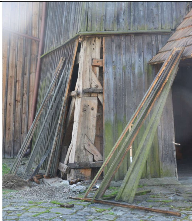
Fot. 5 Odkrywka słupa płn, widoczne połączenie na łapę słupa (1,0-1,5m)
