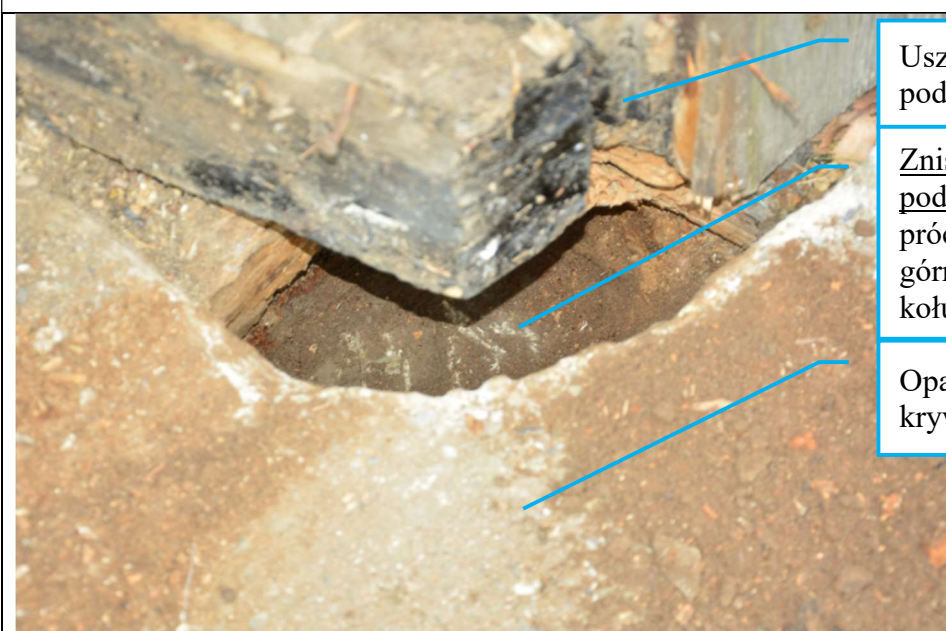
Fot. 21 jw. widok w miejscu zniszczonej podwaliny, widoczna górna powierzchnia cokołu
