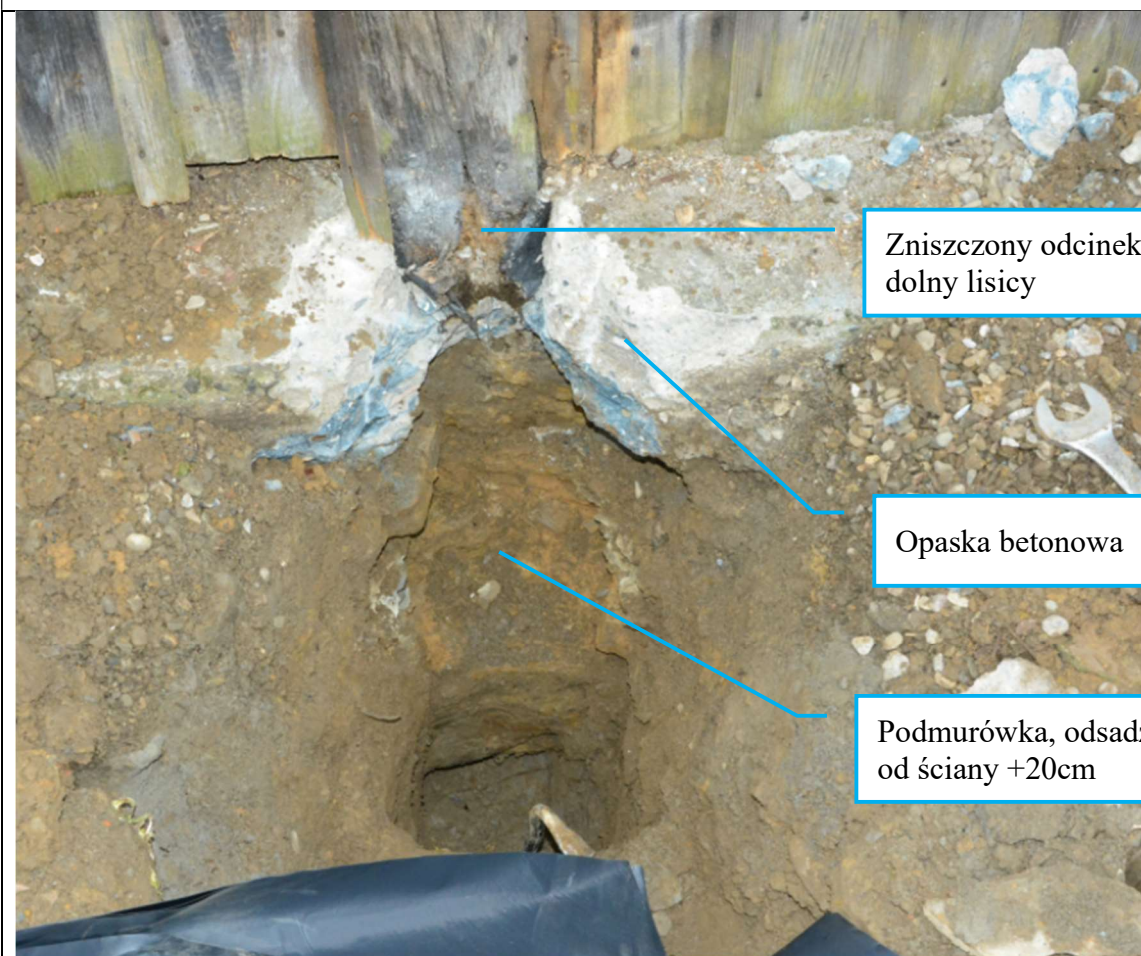
Fot. 19 Odkrywka podmurówki do -1,0m, ściana po stronie ptn - odkrywka 6
